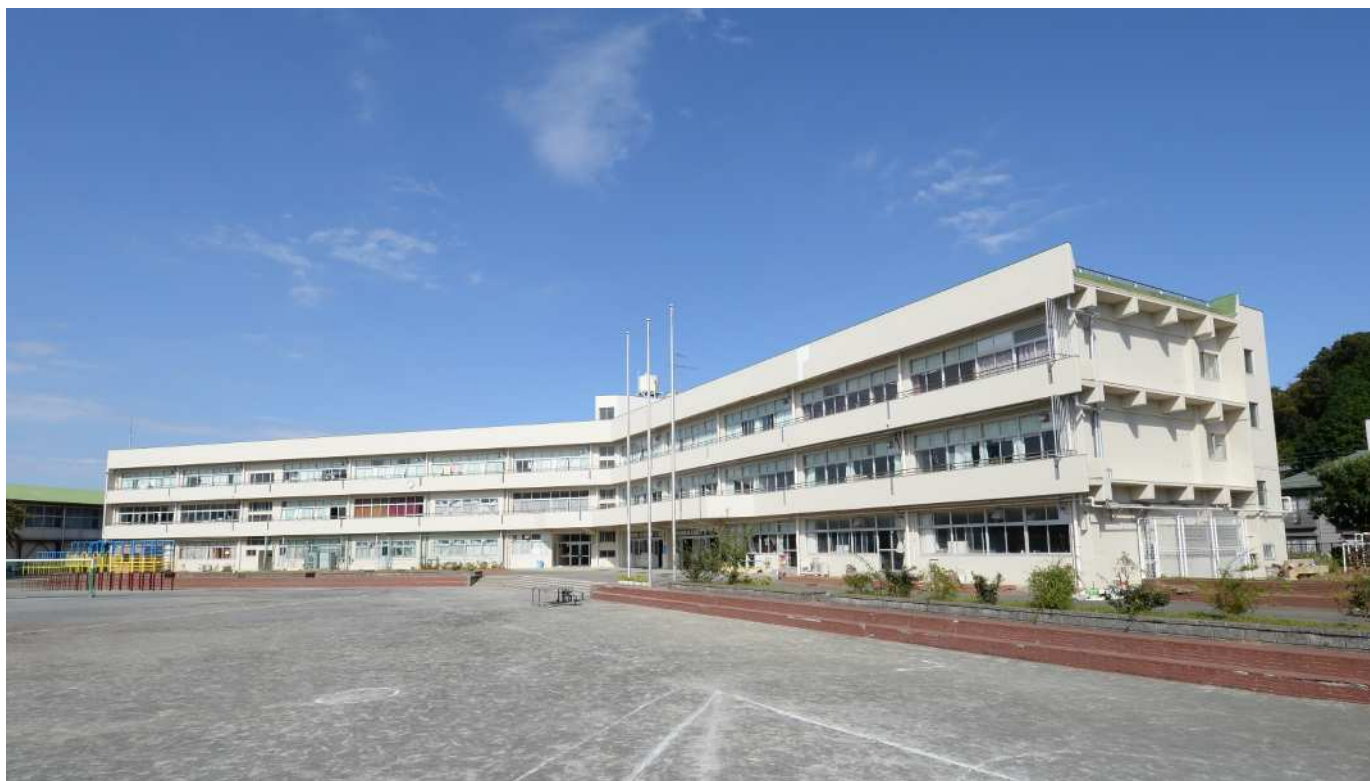
釜利谷東小学校 外壁工事
