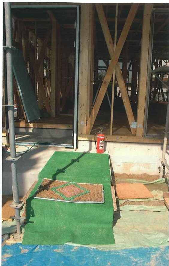
【3】テクノデータハウスの現場の玄関前に敷いた泥落とし用マット。建物内を泥で汚さない工夫
