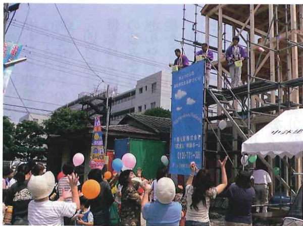
中鉢建設の上棟の餅まきと兼ねて行った構造見学会の様子
